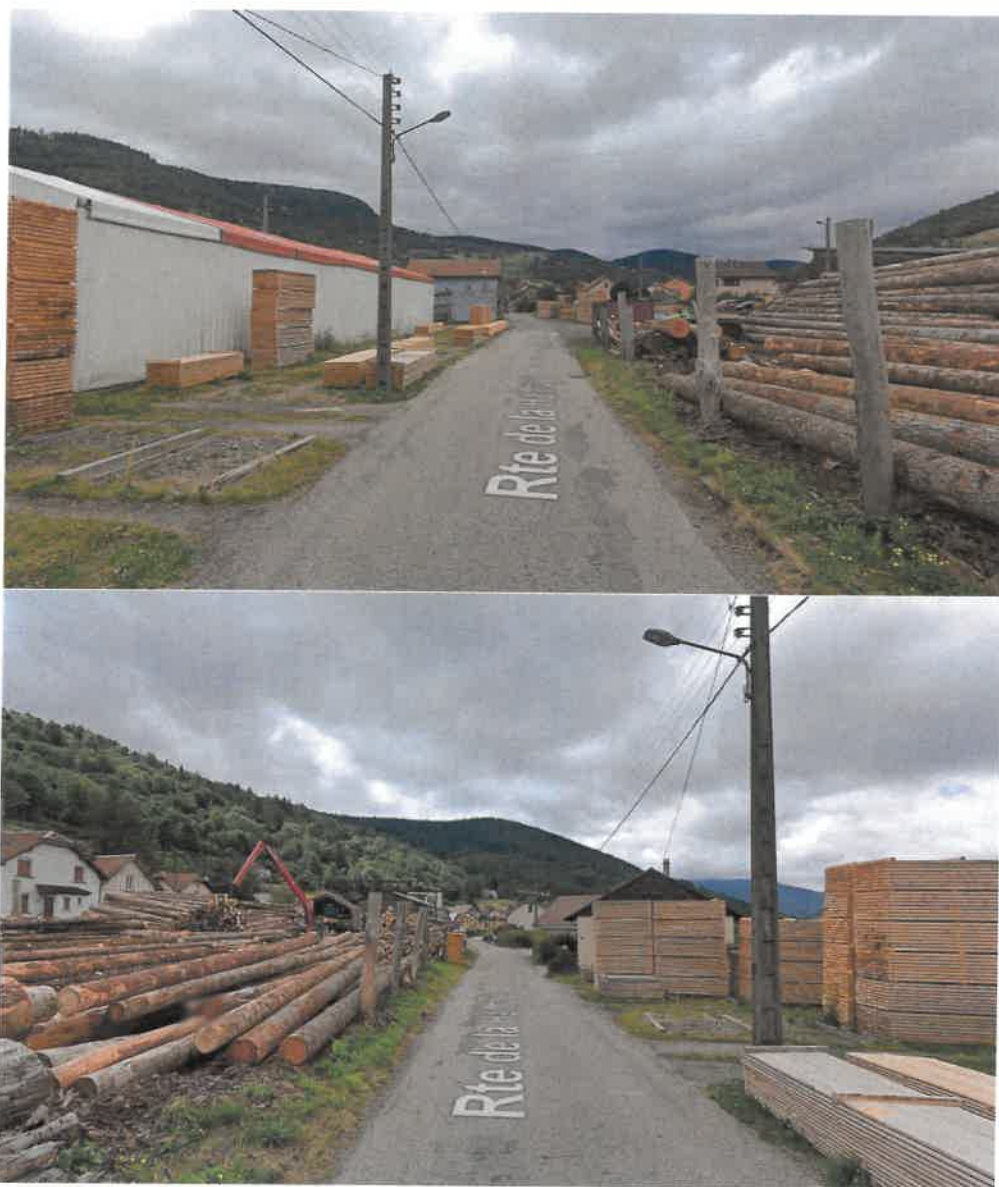
Vues du site de l'entreprise La Jurassienne (Source : google.com/maps)
