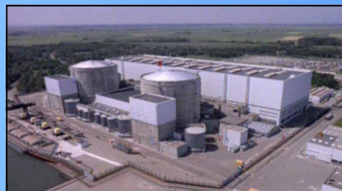
La centrale de Fessenheim (68)
